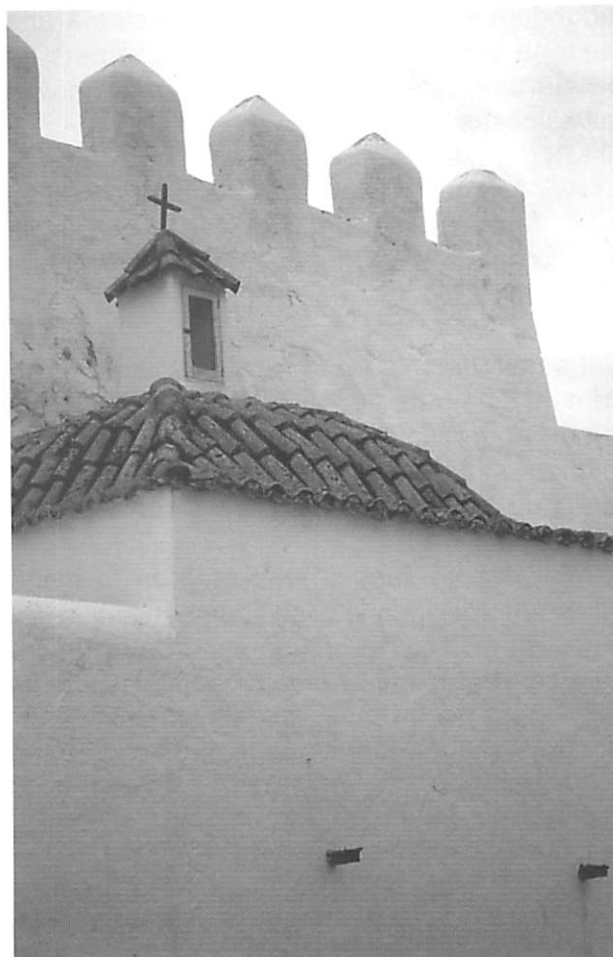
▲ Detall dels merlets que coronen els murs de l'església de Sant Jordi. Foto B. Costa.
