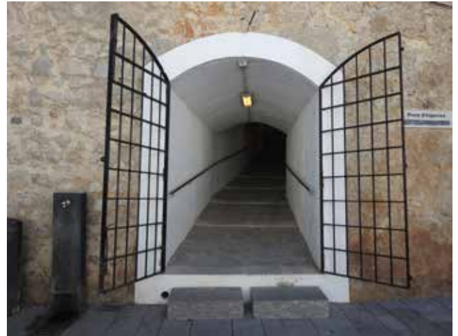
Fig. 8. Estado actual del acceso al antiguo refugio, desde la actual Plaza de España (Foto JHF).
