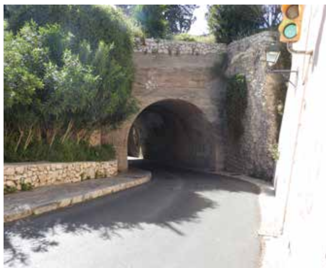
Fig. 12. Actual paso subterráneo en el Baluarte de San Juan (Foto JHF).
