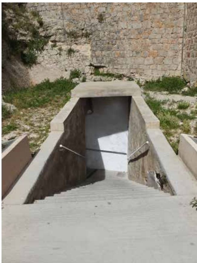
Fig. 11. Acceso al refugio desde es Soto (Foto JHF).
