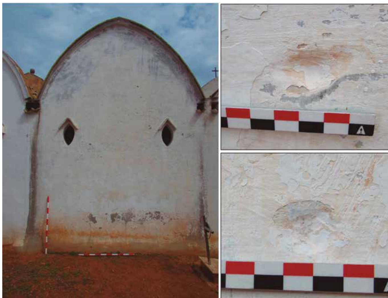
FIGURA 9. Pared trasera del 4º panteón situada junto a los sondeos realizados y que presenta marcas causadas por el impacto de proyectiles. A la derecha, dos detalles.
