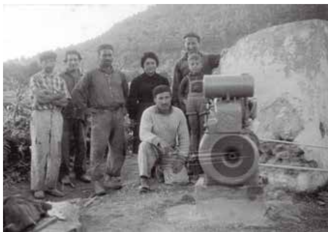
La sènia de l'hort d'en Tanques, a Cala Llonga, dotada d'una moto-bomba nova, fotografiada el dia de la finalització dels treballs d'instal·lació, 1959 (Ferrer & Mezquida, 2009: 53).
