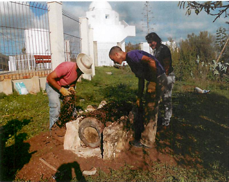
Reconstrucció d'una casera de pedra i tronc de garrover al recinte de la Necròpolis Púnica de Puig des Molins. Recobriment amb posidònia com a aïllament
